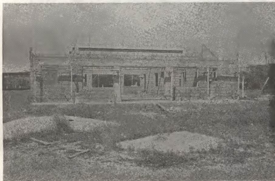
Edificio di Bubali den konstrukshon
